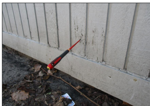
Billede 6: Trænedbrydning i træbeklædning på skur med pyramidetag
